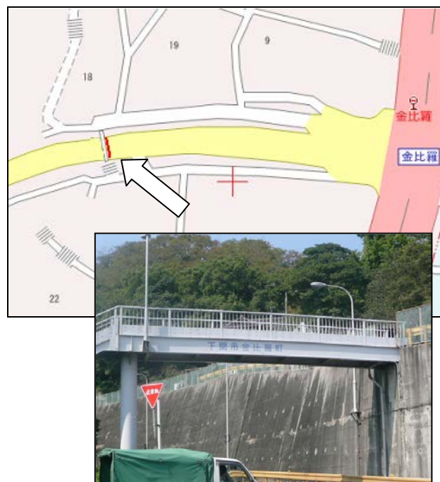
金比羅歩道橋（1ヶ所）
